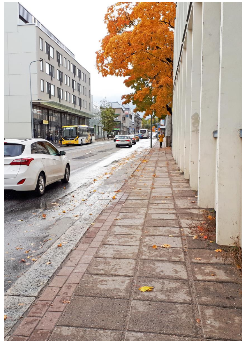
Jalkakäytävän betonikiveys, lokakuu 2019
